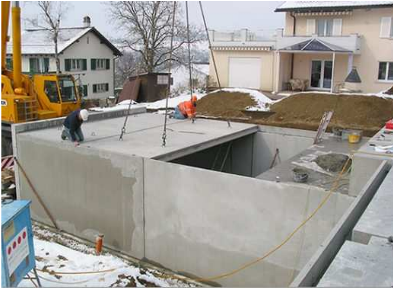
LOSA MACIZA AUTOPORTANTE
